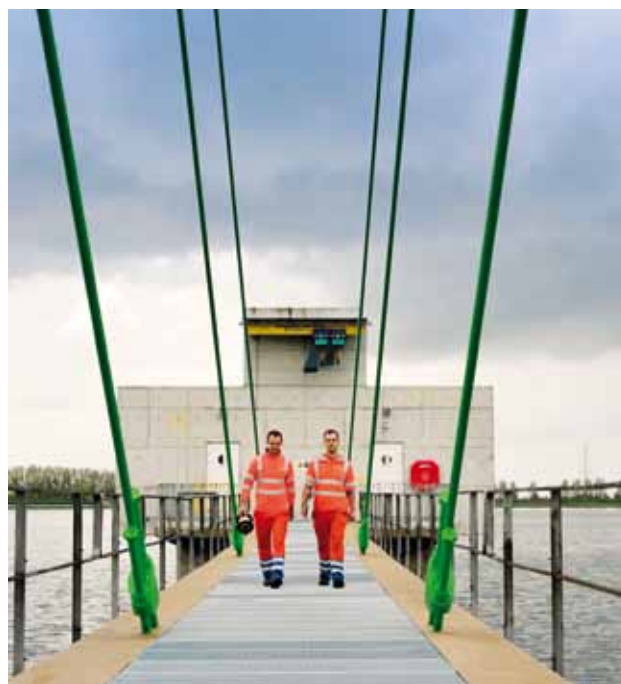
De vernieuwde tuikabelbrug in Kluizen
