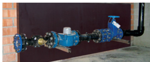
industriële aftakking met leidingdiameter vanaf 80mm
