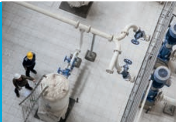
In Haasrode is een nieuw waterproductiecentrum met centrale deelontharding in aanbouw
