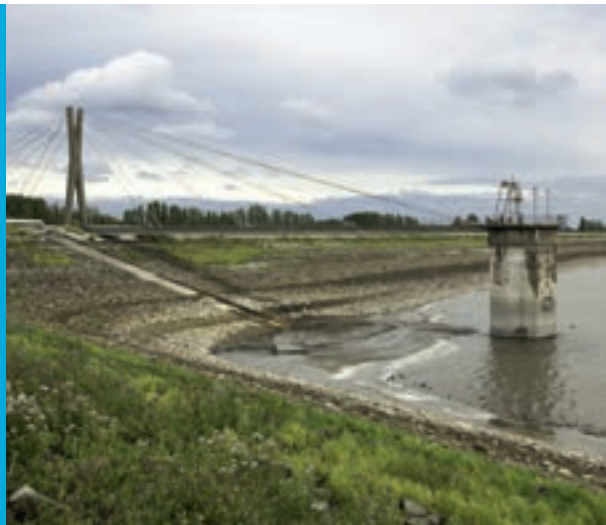
Renovatie watervangtoren Kluizen
