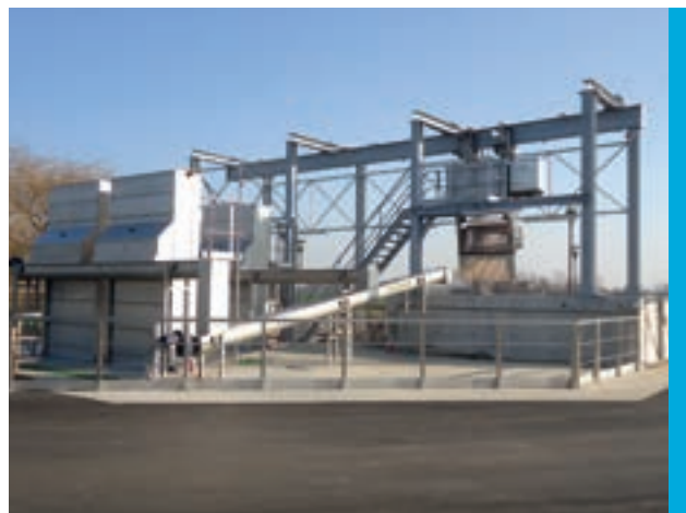
Nieuwe zeefinrichting en kamerfilterpersen voor het waterproductiecentrum De Blankaart (Diksmuide)
