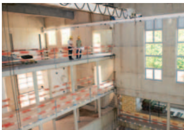
Waterproductiecentrum in aanbouw in Haasrode
