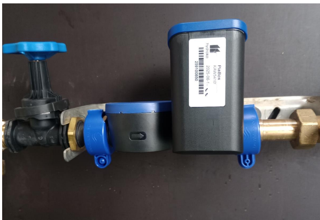
Afbeelding 27: scharnierend, rond verzegelkapje voor watermeter én na debietbegrenzer
