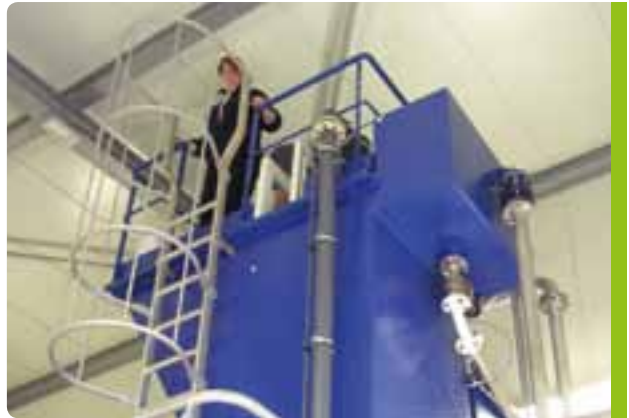
Proefinstallatie voor verwijdering van organisch materiaal in Kluizen
