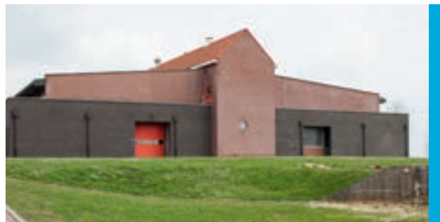
De nieuwe onthardingsinstallatie in Kooigem (Kortrijk)
