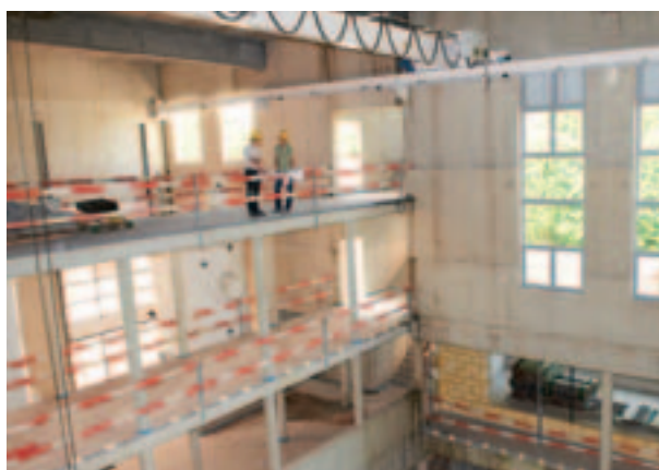
Waterproductiecentrum in aanbouw in Haasrode
