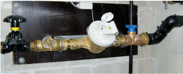
industriële aftakking met leidingdiameter t.e.m. 50 mm
